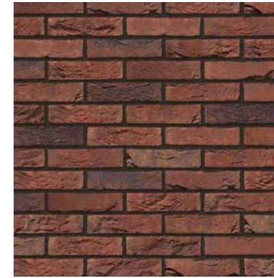
metselwerk als hoofdmateriaal
