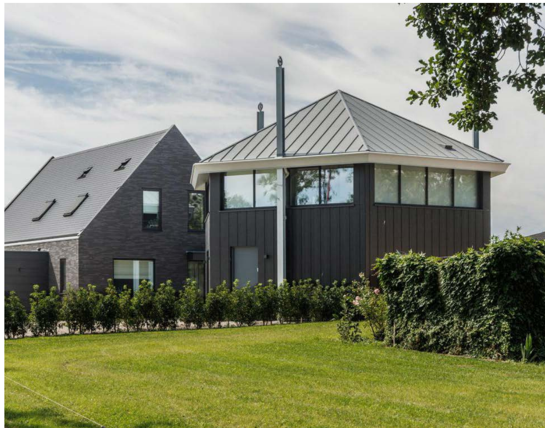
moderne interpretaties van traditionele typologie en bouwvolumes door middel van materiaalgebruik en detaillering
