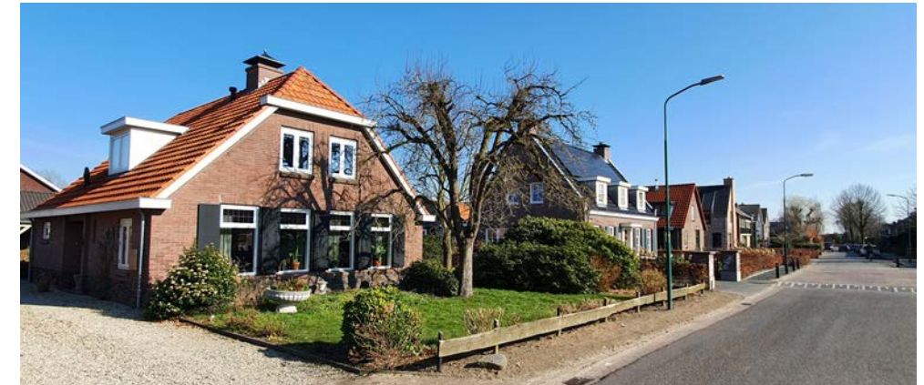
diverse daken in een typisch Achterbergse straat
