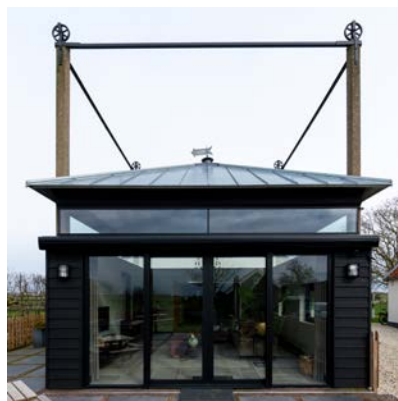
strakke detaillering met glas legt nadruk op de constructie
