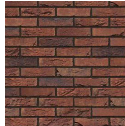
metselwerk als hoofdmateriaal
