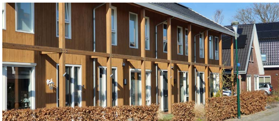
een 'traditionele' balkstructuur maakt een standaard gevel dynamisch
